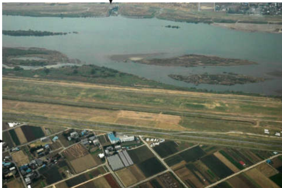
めぬま 妻沼訓練所の格納庫棟
